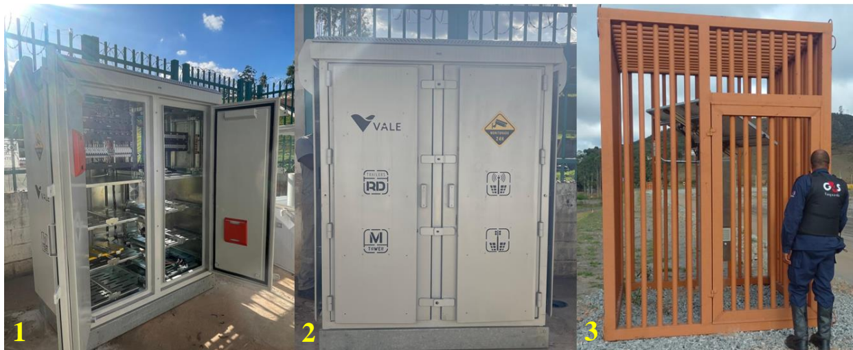
Figura 3. Cofre bastidor (1-2) e gaiola (3) que protegem os equipamentos sísmicos. (Imagem do autor, 2023).
