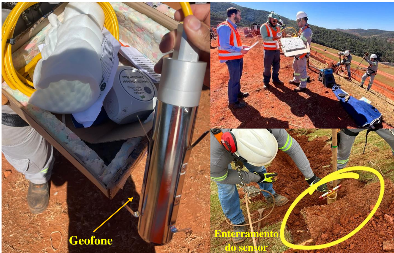
Figura 2. Processo de instalação (enterramento) de geofones em uma barragem de rejeito para o monitoramento microsísmico. (Imagem do autor, 2023).
