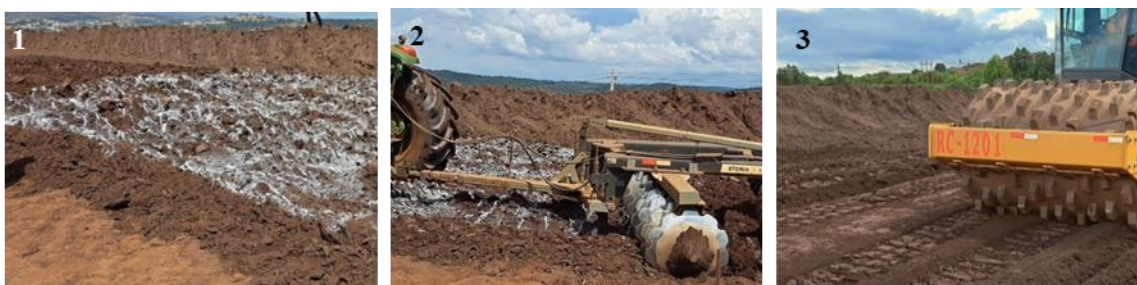
Figura 2. Processo de aplicação (1) do HPA, homogeneização (2) e compactação.
