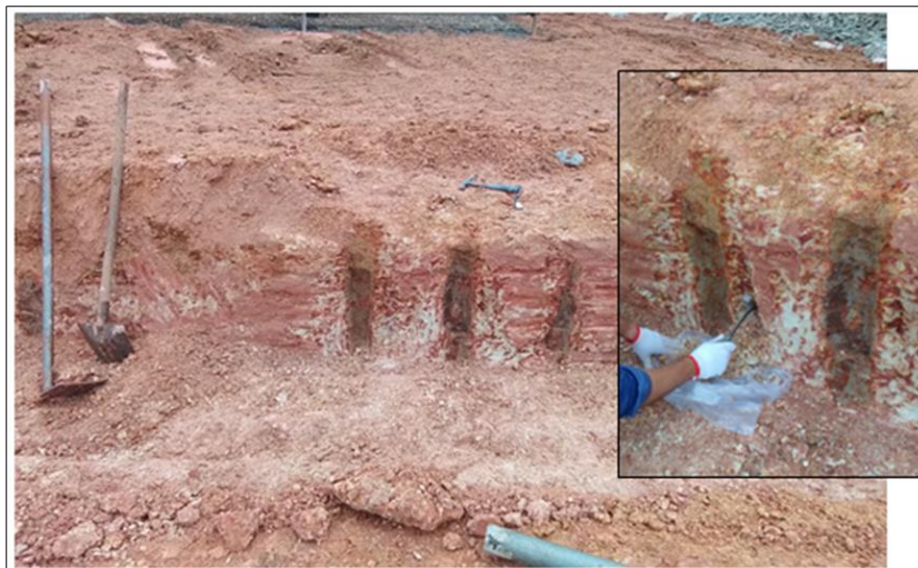
Figura 4. Presença de canalículos nas paredes da trincheira escavada no solo residual maduro.
