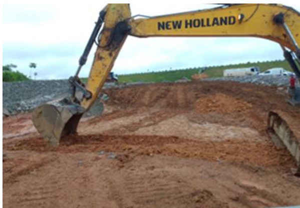
Figura 3. Início da execução da trincheira para coleta de amostras.
