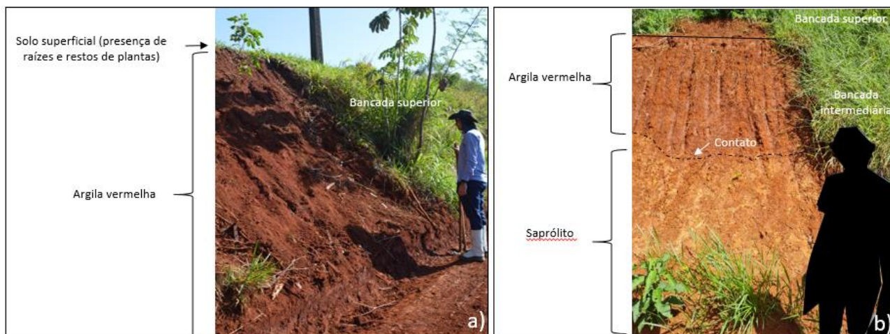
Figura 5. Registro fotográfico representativo dos materiais mapeados: a) bancada superior, com presença de argila vermelha em todos os taludes mapeados; b) bancada intermediária, apresentando o contato entre a argila vermelha e o saprólito.
