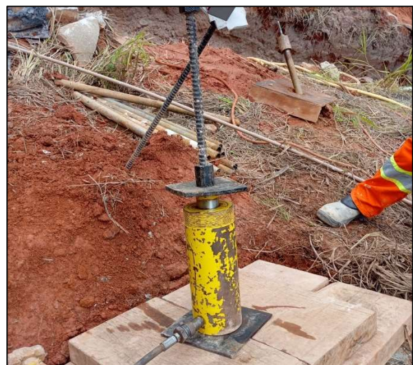
(b) Execução de ensaio de arrancamento.
