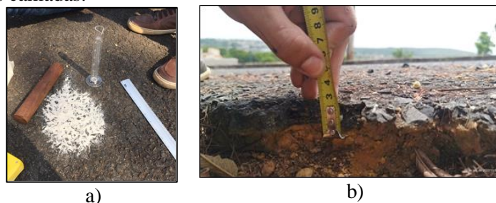
Figura 3. Avaliação da macroestrutura e da espessura das camadas, por meio do a) ensaio de mancha de areia e b) determinação da espessura do pavimento.
