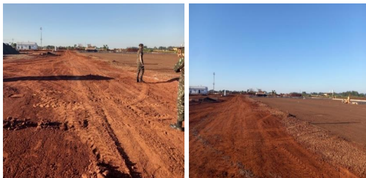
Figura 2. Solo laterítico em seu local de origem no aeroporto de Dourados/MS. Fonte: Os autores.
