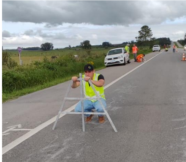
Figura 6. Verificação do afundamento de trilha de roda por meio da treliça.
