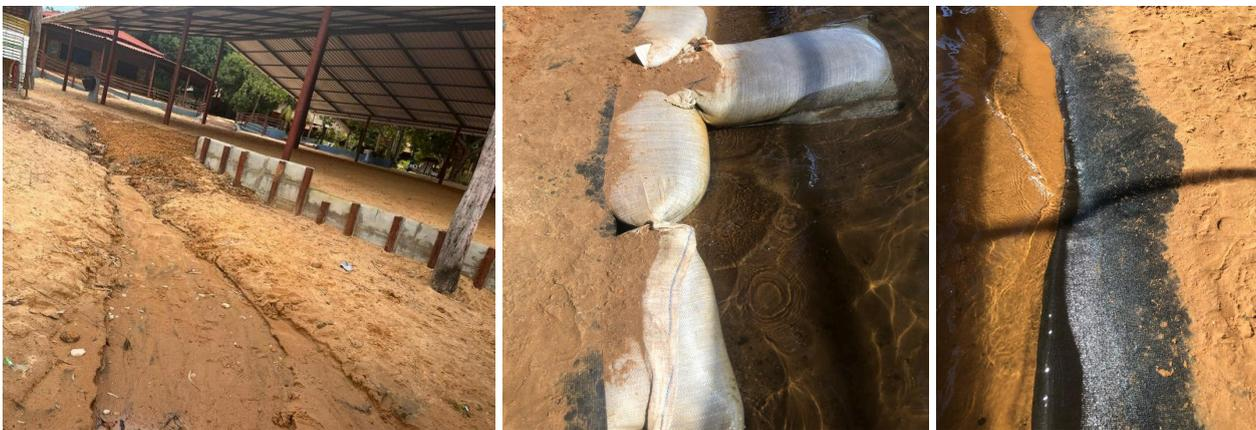
Figura 2. Erosão típica e sistemas empíricos de contenção da areia da praia.
