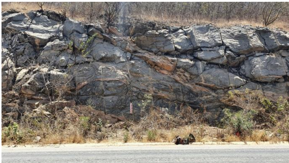
Figura 1. Talude alvo do estudo.
