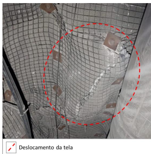
Figura 3. Trecho de solicitação da tela indicando deslocamento do suporte.
