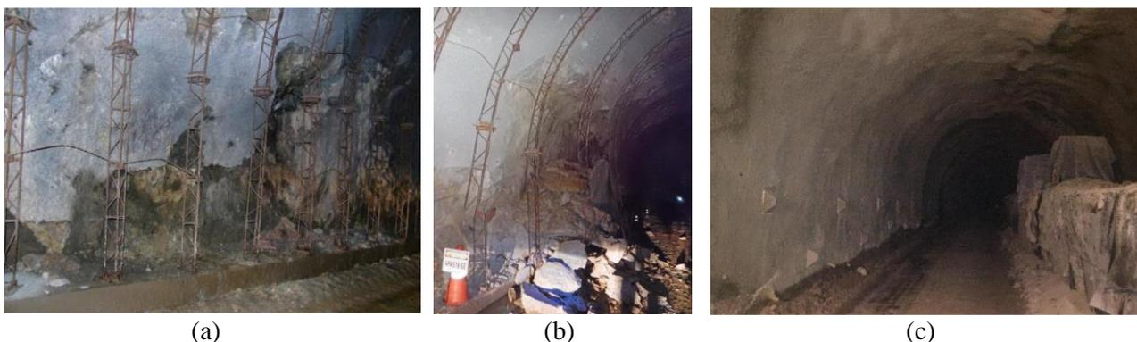
Figura 5. Queda de blocos no túnel da parede esquerda do túnel do GASDUC III.
