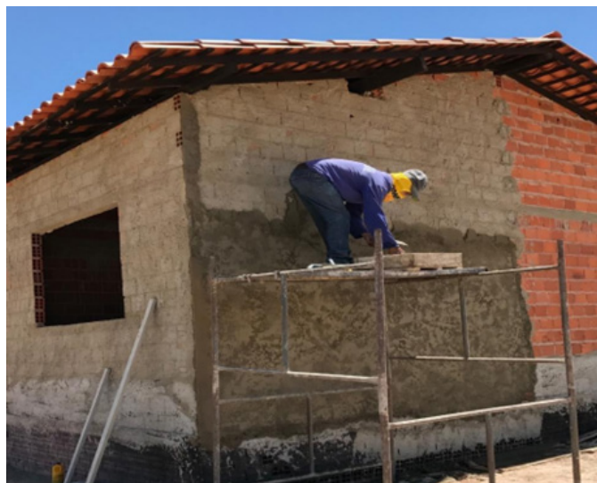
Figura 7. Aplicação da argamassa termoacústica
