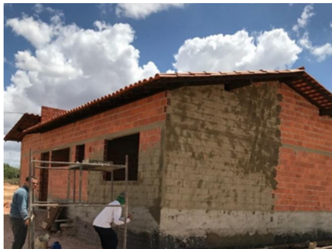
Figura 6. Foto aplicação do chapisco
