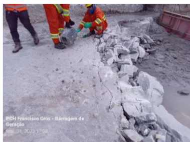
Figura 9. Remoção de blocos de rocha
