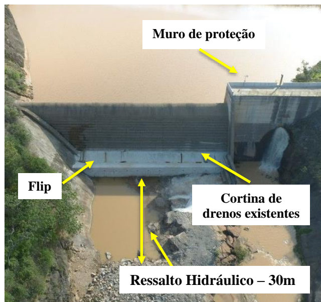
Figura 8. Adequação das estruturas.
