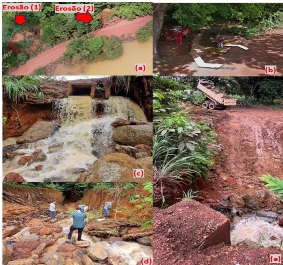
Figura 2.1. Pontos de erosão 1 e 2 (a), registro da árvore antes da erosão (b) no ponto 1 frente ao extravasor (c), lançamento de blocos de rocha para conter a erosão (d) e retirada de amostras para análise próxima erosão no ponto 1 (e).
