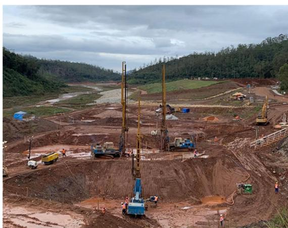
Figura 5. Execução do Jet Grouting com 3 equipamentos em escavações escalonadas.
