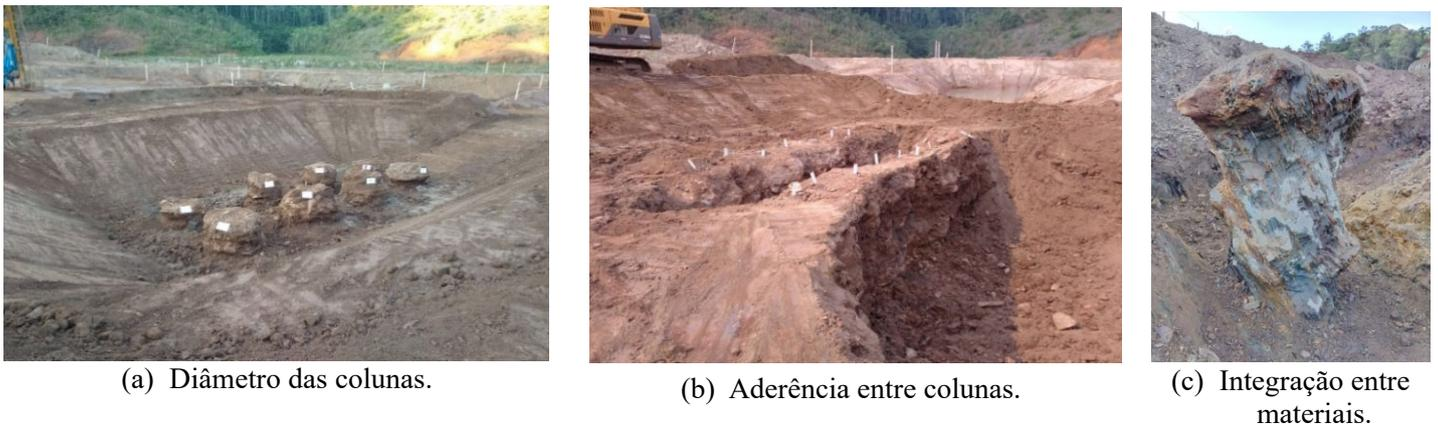
Figura 3 – Verificação das colunas teste.
