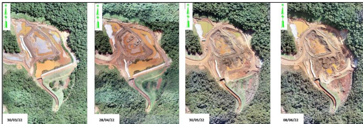
Figura 8. Desenvolvimento das obras para descaracterização – Imagens aéreas
