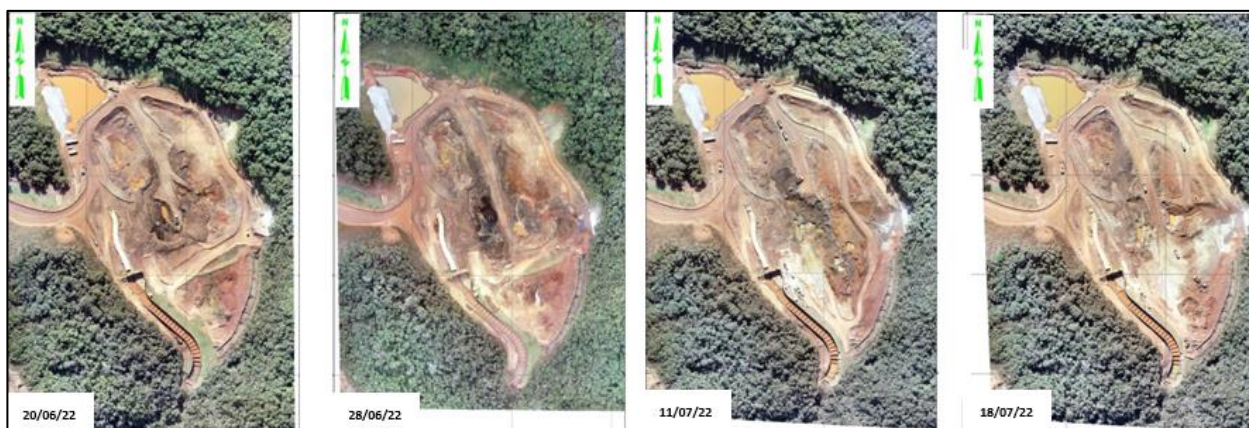
Figura 9. Desenvolvimento das obras para descaracterização – Imagens aéreas
