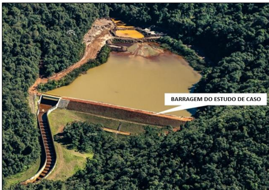
Figura 1. Imagem aérea do barramento anteriormente à descaracterização
