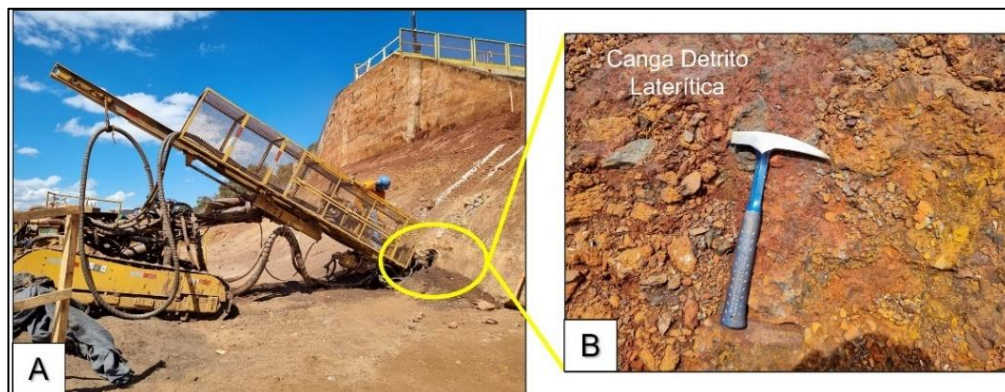
Figura 8. A) Visada para a praça de aterro compactado utilizado como plataforma de apoio para a execução das injeções na ombreira direita. B) Amostra de mão de canga detrito-laterítica tratada.
