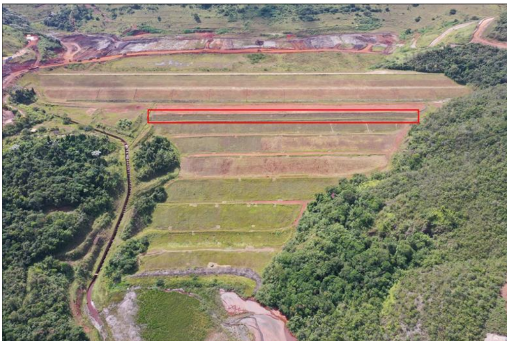
Figura 1. Atividade de supressão vegetal na Barragem Sul Superior pelo iCUT.
