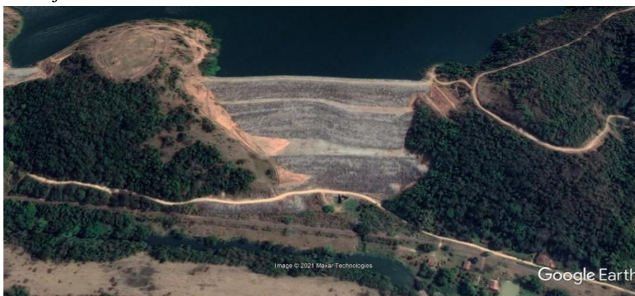
Figura 1 – Vista aérea do Dique Estaca 2 (reservatório ao funfo). Fonte: Google Earth
