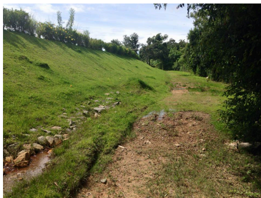
Figura 2. Detalhe do dreno de enrocamento no pé do talude da lagoa trabalhando afogado pelo percolado.
