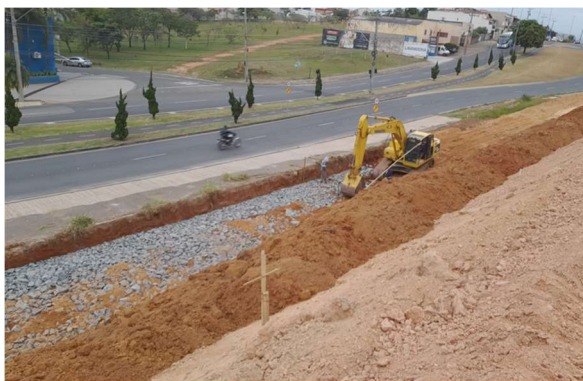
Figura 9. Preparação do terreno do Muro 1 Fonte: De autoria própria
