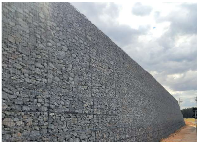
Figura 14. Face do Muro Fonte: De autoria própria
