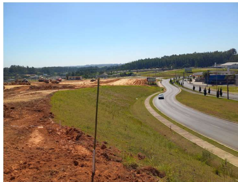
Figura 1. Vista da lateral do terreno, local da construção de um dos muros Fonte: De autoria própria
