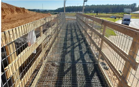
Figura 12. Montagem do dos gabiões com gabarito Fonte: De autoria própria BELGO (2022)
