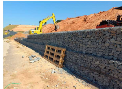
Figura 15. 1 Compactação do aterro Fonte: De autoria própria
