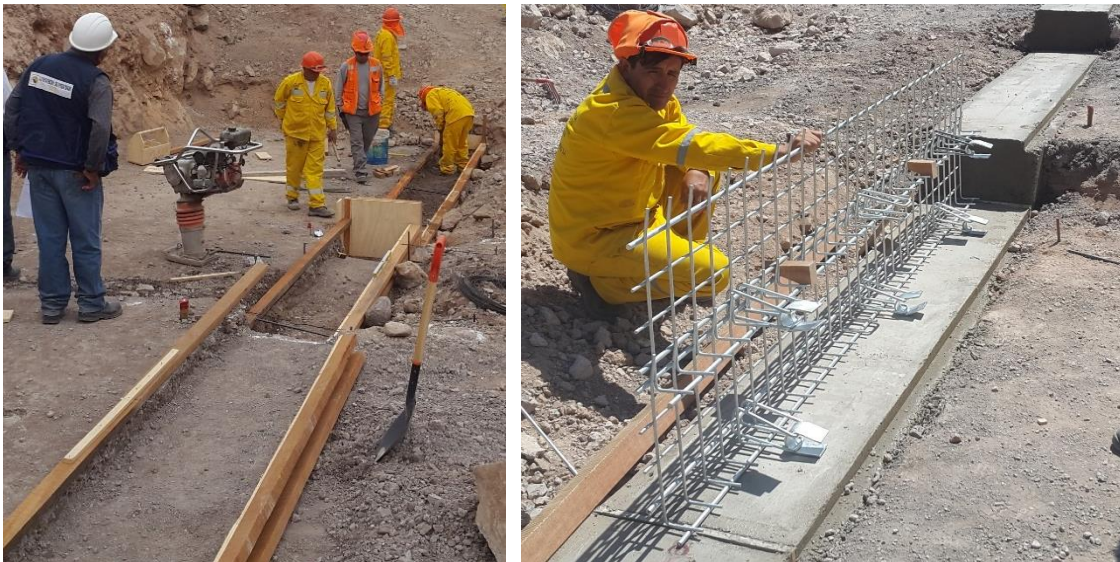
Figuras 4 e 5. Soleira em execução para alinhamento do paramento frontal da contenção. FONTE: Freyssinet Tierra Armada Perú S.A.C.
