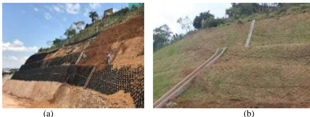
Figura 9. (a) Execução de preenchimento de geocélulas de PEAD (b) Vegetação estabelecida após um mês.
