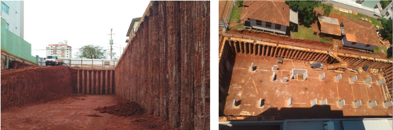
Figura 7. À esquerda a escavação do terreno, permanecendo as estacas enterradas apenas comprimento de ficha de projeto, e à direita o início dos pilares da mesoestrutura sobre os tubulões. Fonte: Camerini e Serraglio (2022).
