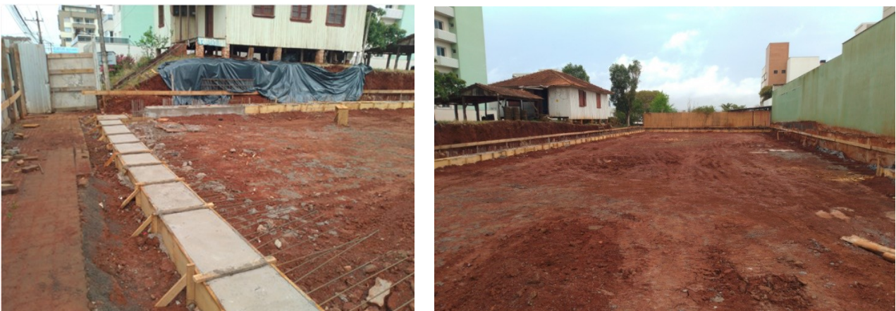
Figura 3. Detalhe da viga de coroamento da cortina e esperas superiores antes das escavações. Fonte: Camerini e Serraglio (2022).
