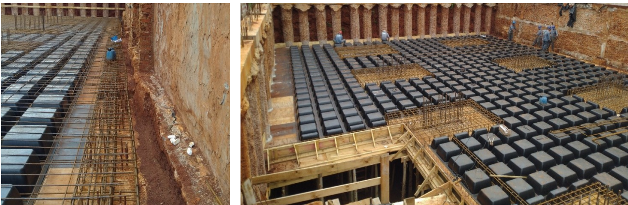
Figura 8. À esquerda de piso da garagem inferior: primeiro apoio das cortinas, onde acaba a fixa e inicia o comprimento livre. À direita preparação para concretagem do apoio intermediário: laje de piso da garagem 1. Fonte: Camerini e Serraglio (2022).
