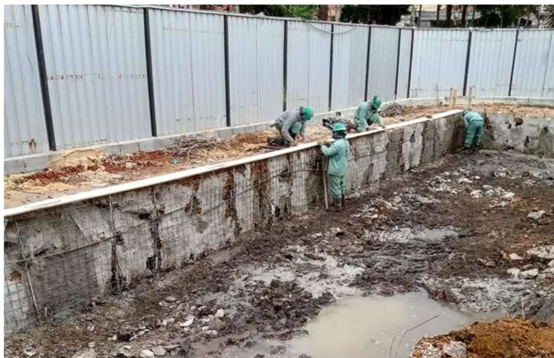
Figura 5. Início das escavações para o solo grampeado
