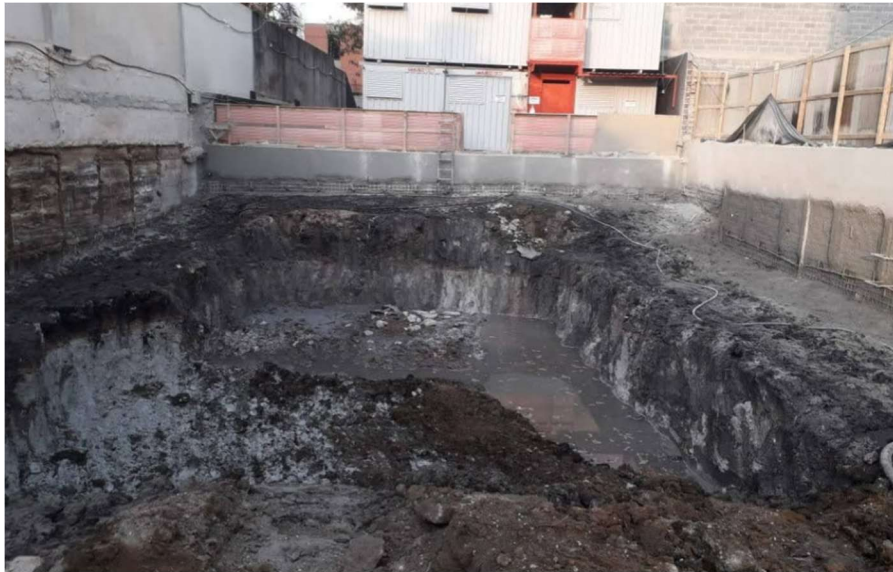
Figura 8. Escavação no centro da obra para rebaixar o lençol freático
