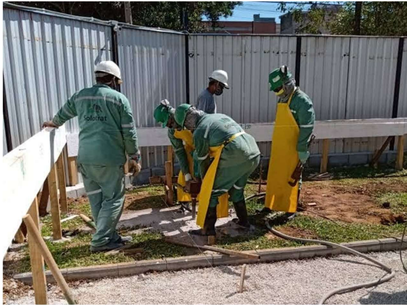
Figura 4. Perfuração de grampos verticais
