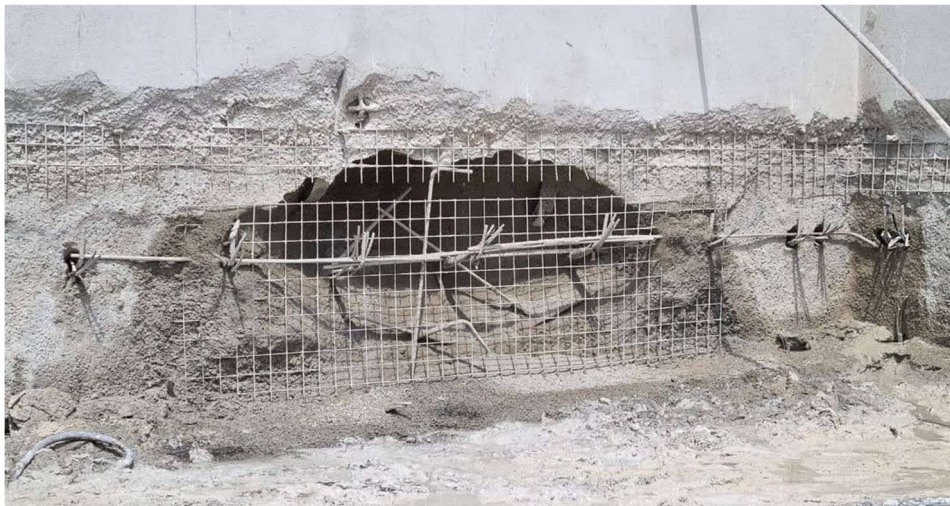
Figura 7. Trecho já com a tela metálica instalada
