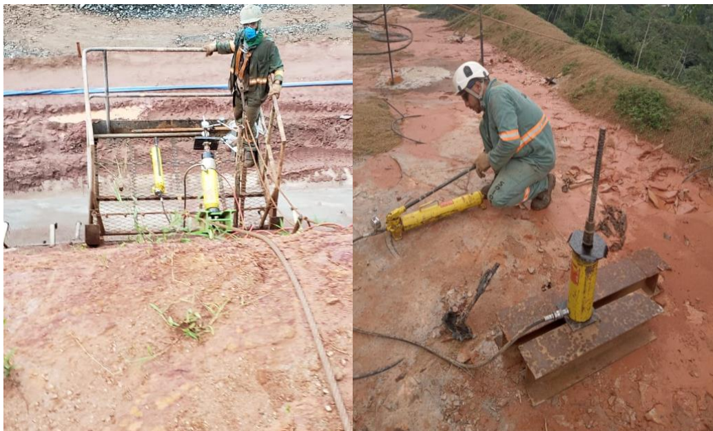
Figura 6. Montagem de ensaio de arrancamento sub-horizantal no talude 2 à esquerda e vertical à direita
