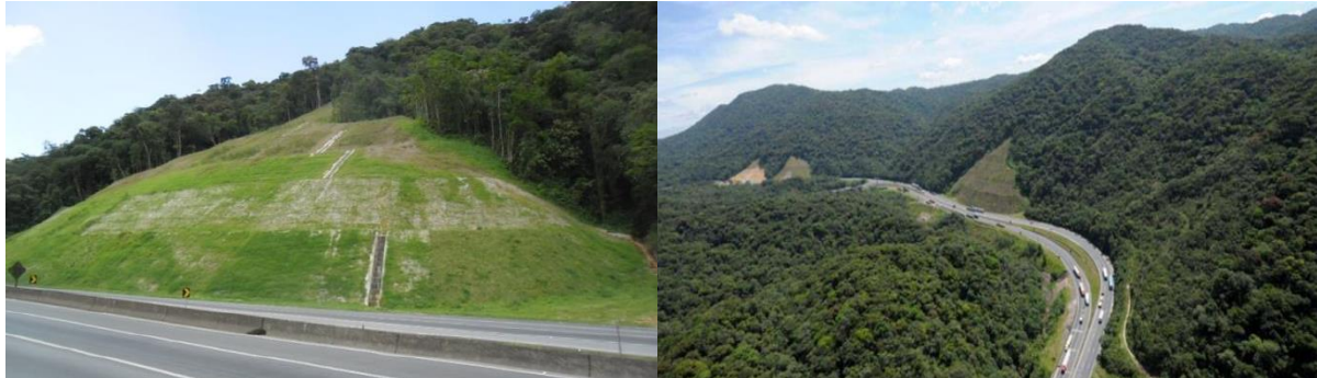
Figura 2. Talude de estudo e localização na BR-376 Fonte: ALS, 2019.
