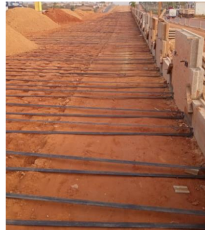
Figura 6 - Muro com Fitas Sintéticas
