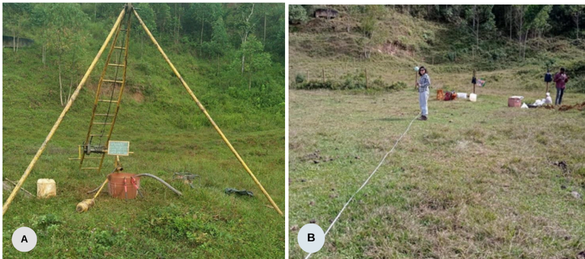
Figura 3 – Investigações geotécnicas: A) execução de sondagem à percussão SPT (SP-04); B) execução do CE (seção 1).
