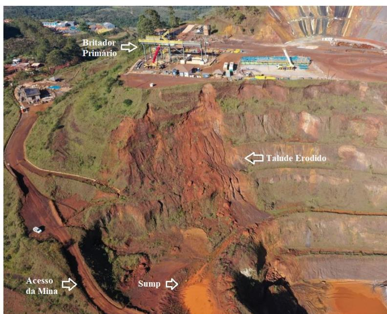
Figura 1. Localização do Talude Erodido.
