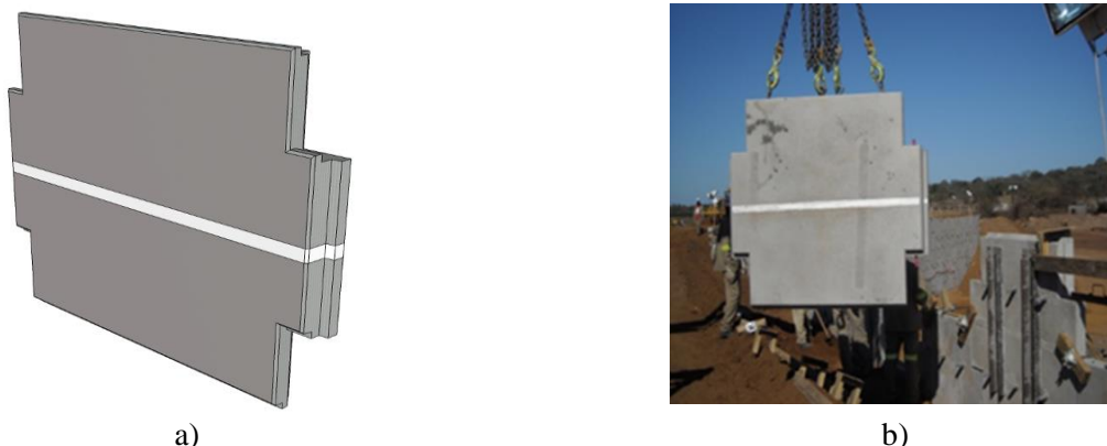
Figura 5 – Solução em painéis compressíveis: a) Esquema de configuração da placa; b) Imagem de placa compressível sendo empregada em campo, Smith (2017).
