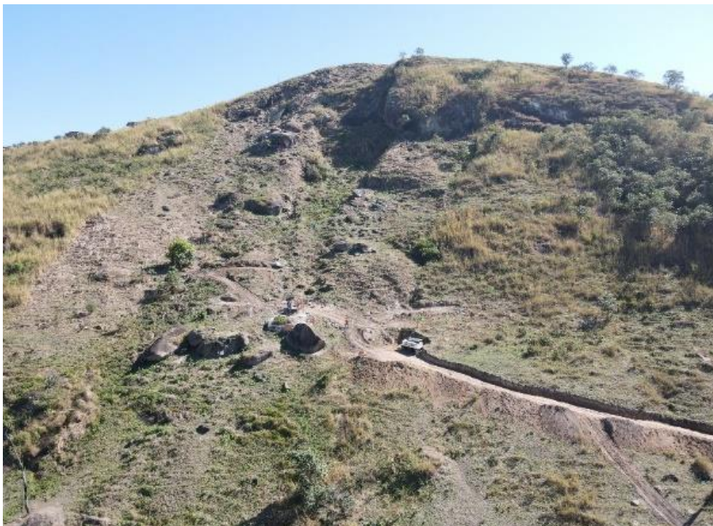
Figura 9. Preparação da área para execução das soluções.
