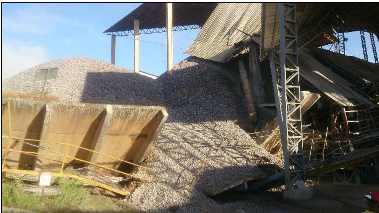
Figura 2. Cortina colapsada
