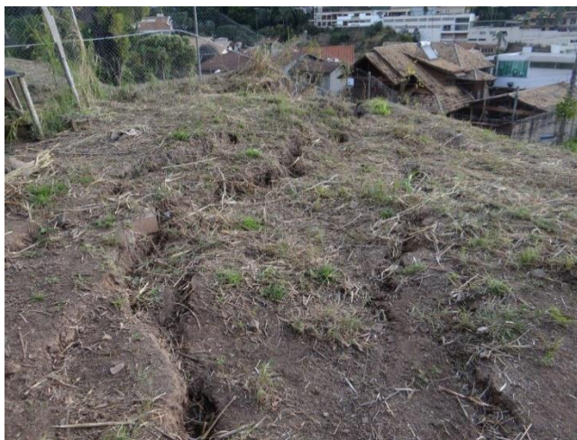
Figura 8. Trinca transversal no terreno. (O autor, Julho/2018).
