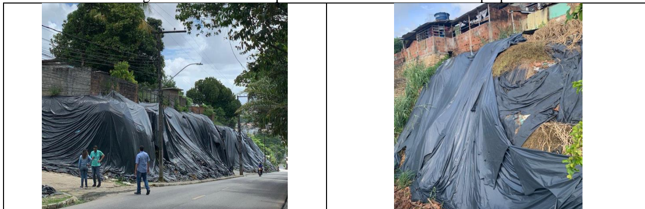
Figura 1. Encosta 1 a esquerda e Encosta 2 a direita. Fonte própria
