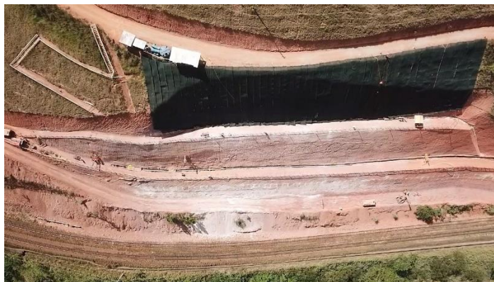
Figura 6. Execução pelo método descendente
