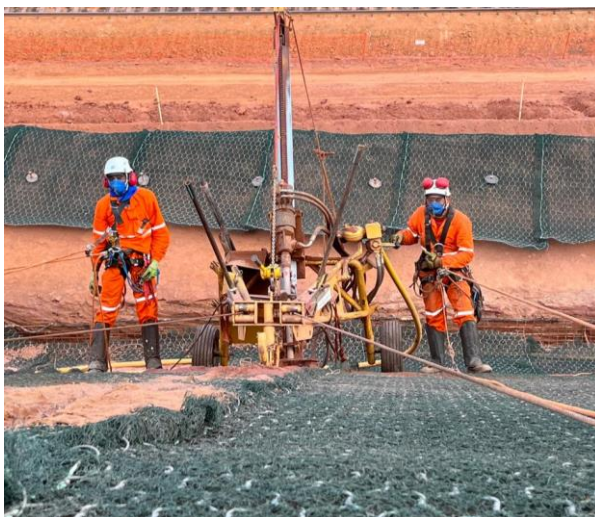
Figura 5: Perfuração do talude 02 com Wagon Drill
