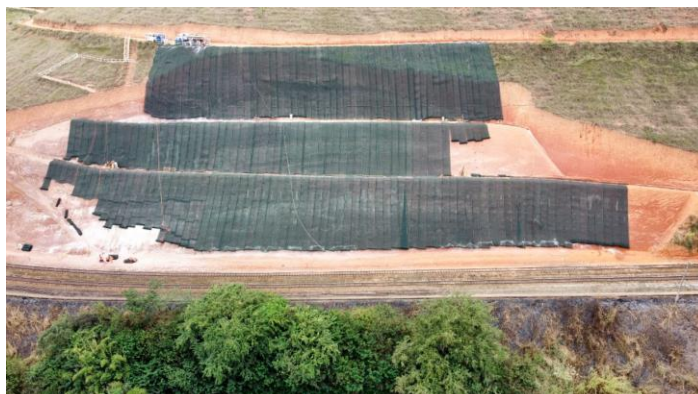
Figura 7. Instalação do sistema de telas MacMat R1
