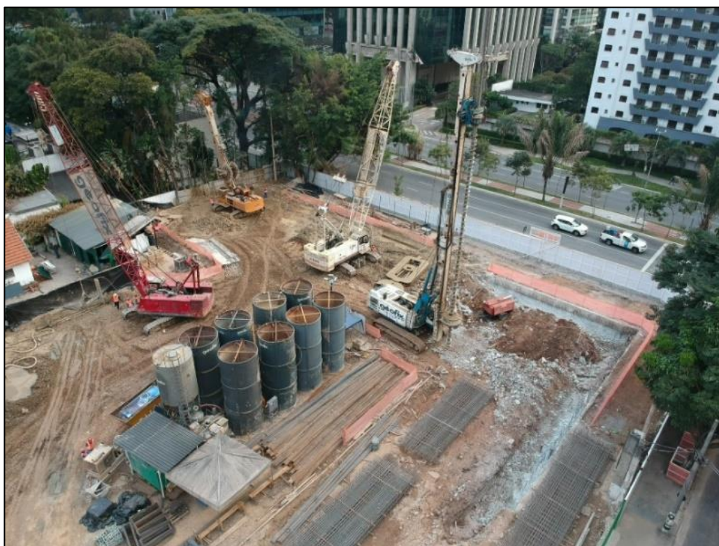
Figura 5. Canteiro de obra durante a escavação de parede diafragma.
