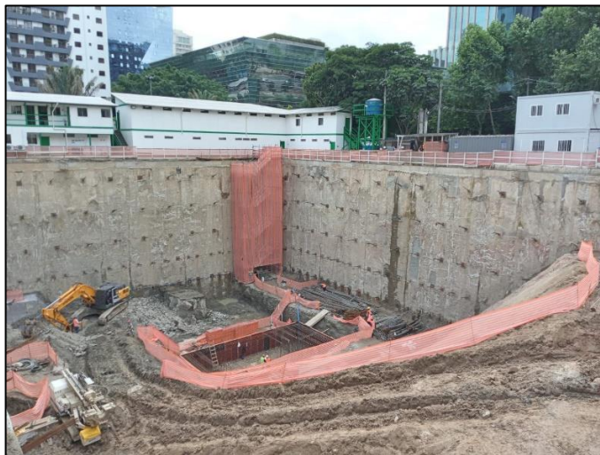
Figura 1. Parede Diafragma durante a escavação da obra.
