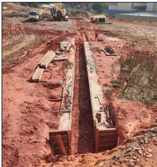
Figura 2. Execução de mureta-guia.
