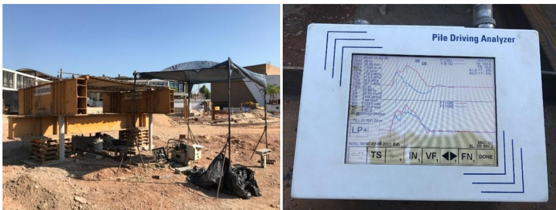
Figura 2. (a) PCE em execução (b) PDA ( Pile Driving Analyzer ) utilizado nos ensaios de carregamento dinâmico (Tsuchiya, 2021) - estudo de caso abordado neste artigo.
