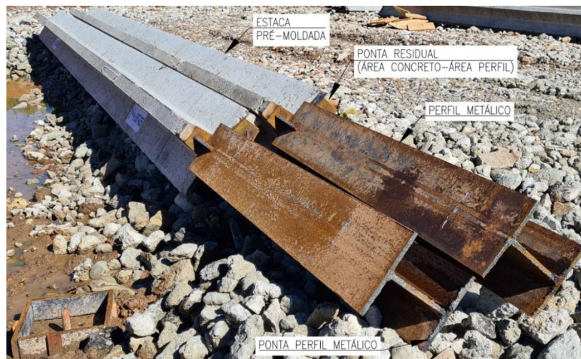
Figura 2. Considerações para as resistências geotécnicas na solução em estaca mista.
