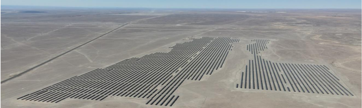
Figura 1. Vista panorámica de la planta solar.
