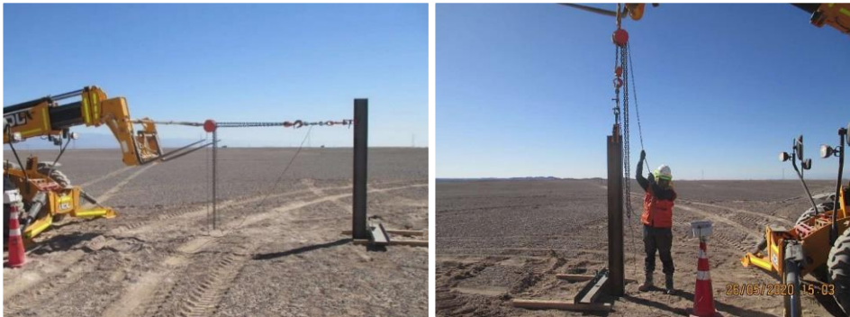
Figura 5. Ejecución de pruebas de carga horizontal (izquierda) y vertical (derecha)
