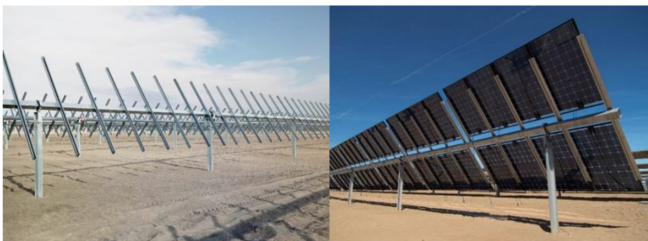
Figura 8. Proceso constructivo del hincado de pilotes y armado de estructuras
