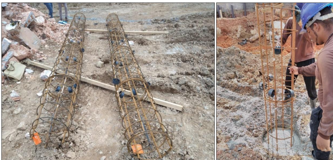
Figura 3. A) Armações prontas. B) Armação posicionada no centro da escavação.
