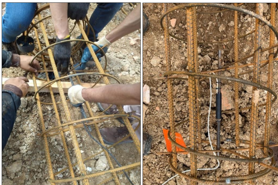
Figura 2. A) Fixação do segmento de barra com strain gages . B) Segmento de barra fixado.
