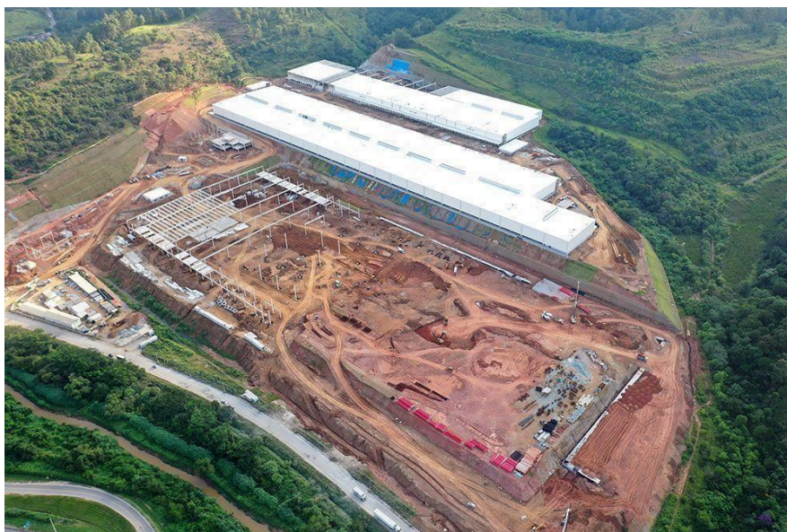
Figura 2. Foto capturada durante a construção do centro logístico
