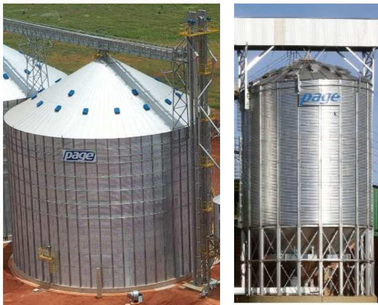
Figura 2. a) silos verticais de fundo plano, b) silos verticais de fundo cônico. Disponível em https://www.page.ind.br/
