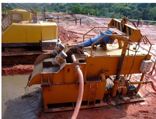
Figura 1 – Vista do Reciclador
