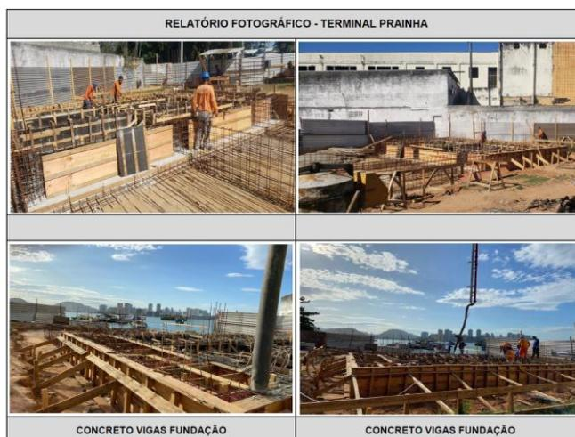
Figura 9. Execução das fundações tipo caixão da sala de espera de Prainha de Vila Velha/ES
