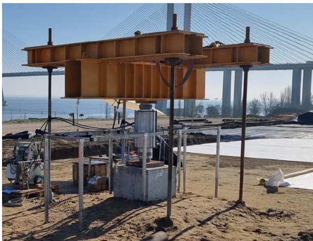
Figura 12 - Ensaio de carga de compressão.
