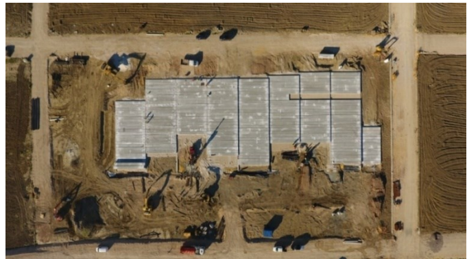
Figura 8 - Fotografia aérea da fundação do palco - zona de fundação direta constituída por lajes alveolares.
