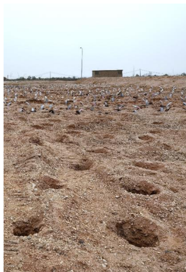
Figura 4. Execução de drenos verticais pré-fabricados (pré-furos).
