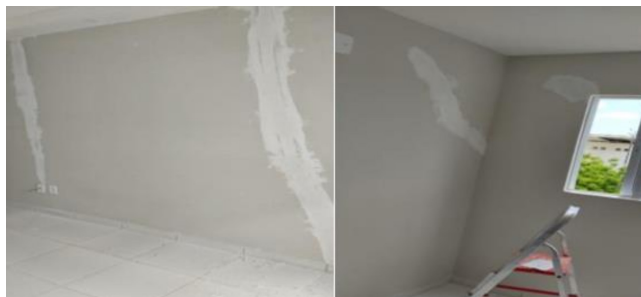
Imagem 3: Correção nas fissuras na parede.
