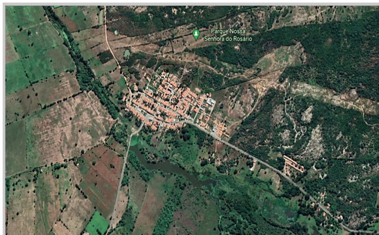
Figura 1. Barragem do distrito do Rosário, localizado no município de Milagres–CE.
